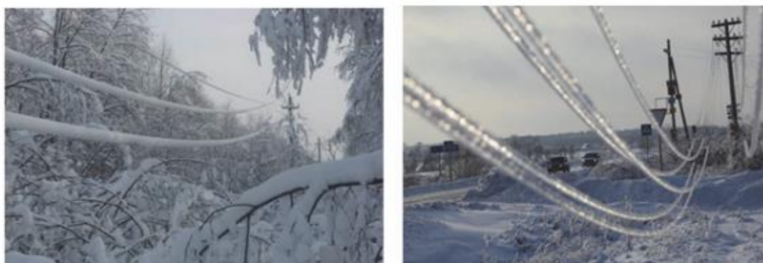
2.1 – сурет. Әуелік электр желісінің сымдарында мұз шөгінділері
