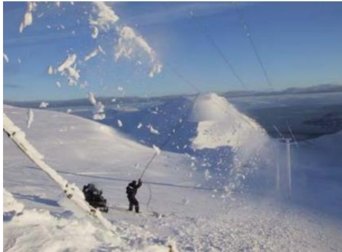
3.6 – сурет. Мұзды кетірудің механикалық әдісі [21]
