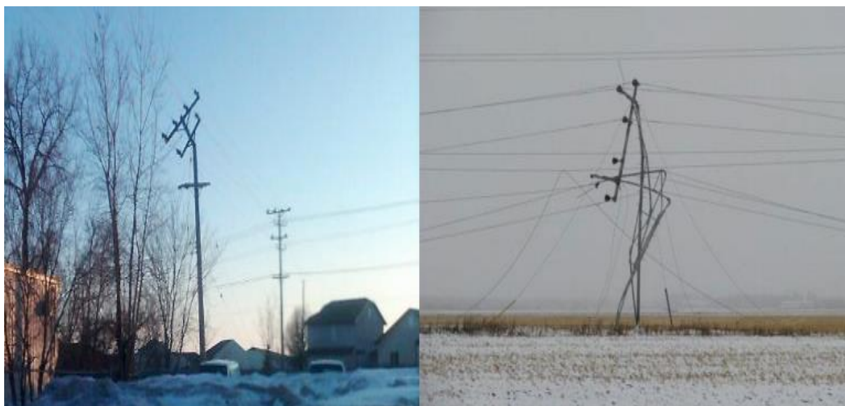
1.3 – сурет. Тіректердің зақымдануы және тірек өрті салдарынан мұнараның иілуі
