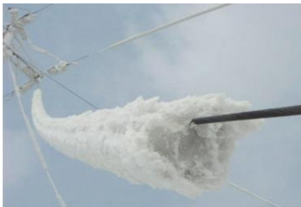
2.2 – сурет. Электр желісі сымдарының мұздануы
